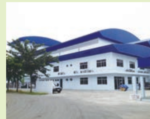
稼働間近のFTI新工場
